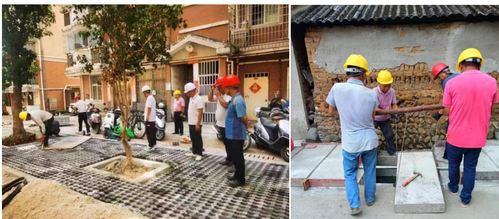
图片 2 现场施工改造
