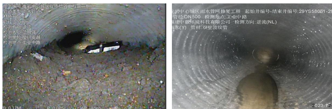
机械清除前（左）VS 机械清除后（右）
